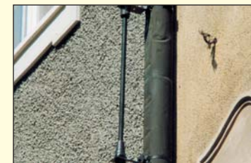
Mikro-Mobilfunksender an Regenrinne
